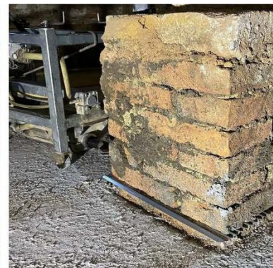
Säulentrockenlegung eines böhmischen Gewölbes
