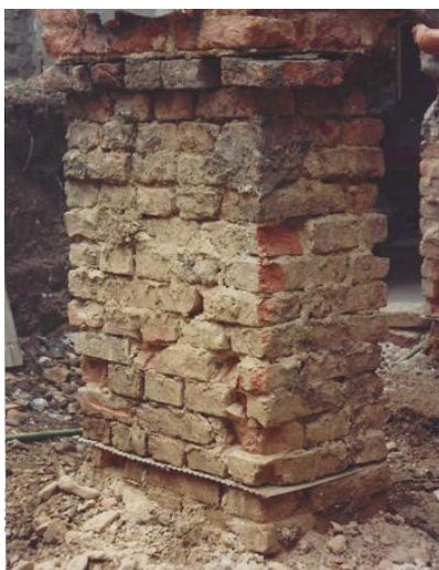
Pfeilertrockenlegung
