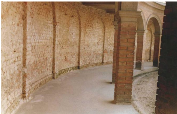
Kreuzweggebäude des Friedhofseinganges in Korneuburg (NÖ) mit eingebauter Horizontalsperre im linken Bild, abgeschlossene Renovierung im rechten Bild
