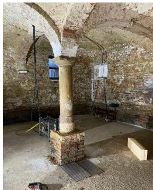
Säulentrockenlegung eines böhmischen Gewölbes
