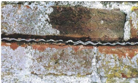
Überlappung der HW-Edelstahlplatten
