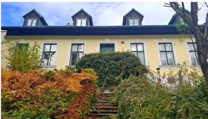
Haus Beethovengang Nr. 16 nach der Renovierung
